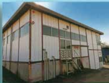
2次排水処理施設
