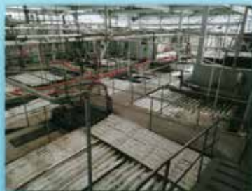
1次排水処理施設
